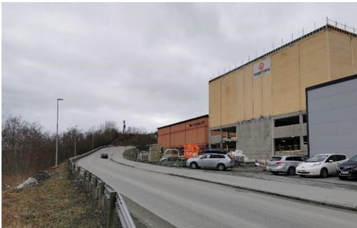
Figur 41. Illustrasjon. I dag dominerer de store idrettsbyggene med bratt terreng mot elva, flere adkomster, staten på en bratt bakke og en sving gjør at det blir utfordrende å plassere brua her.
