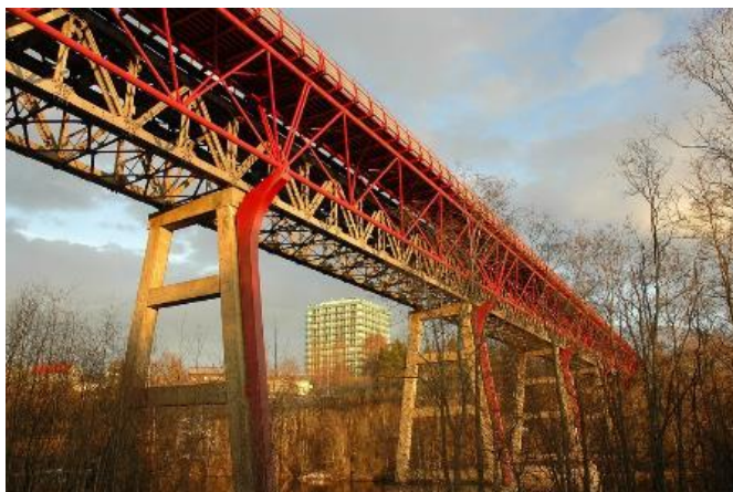
Figur 31 Påhengt gangbru på Stavne bru
