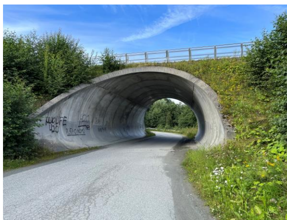
Figur 28 Gangvei gjennom kulvert
